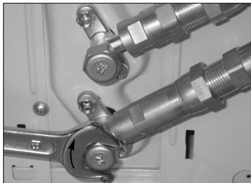
7. Após a conclusão dos trabalhos de 1 – 6 verifique a estanqueidade de todos os pontos de união com um spray detector de fugas ou com água e sabão. Na eventualidade de verificar a formação de bolhas é porque existe uma fuga, tendo de apertar novamente as uniões roscadas com o auxílio de uma chave de bocas.
