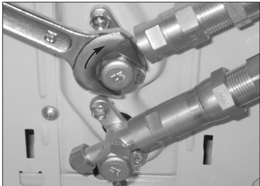
6. Retirez le recouvrement de la soupape d'arrêt inférieure à l'aide d'une clé à fourche simple SW 19. Ouvrez la soupape d'arrêt en la tournant
