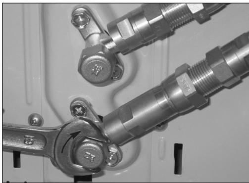
7. Après avoir terminé les étapes 1 – 6, contrôlez l'étanchéité de tous les raccords à l'aide d'un spray de détection de fuite ou d'une lessive de savon. En cas de formation de bulles, la conduite n'est pas étanche et il faut resserrer une nouvelle fois les raccords vissés à l'aide d'une clé à fourche simple.
